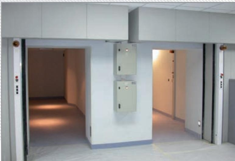
Depuis 30 ans, nos ingénieurs et techniciens conçoivent, produisent et installent des portes plombées et neutroniques, des armoires, des sas et des parois ou cloisons de radioprotection pour des bunkers de Radiothérapie et des services de Médecine Nucléaire dans le monde entier. Quels que soient le poids, la taille ou le lieu, les équipes de DIB Radioprotection ont à cœur de satisfaire vos exigences de radioprotection et d'apporter à votre personnel et vos propres clients un environnement sûr.
